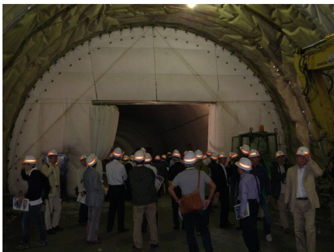
▲現場視察状況
