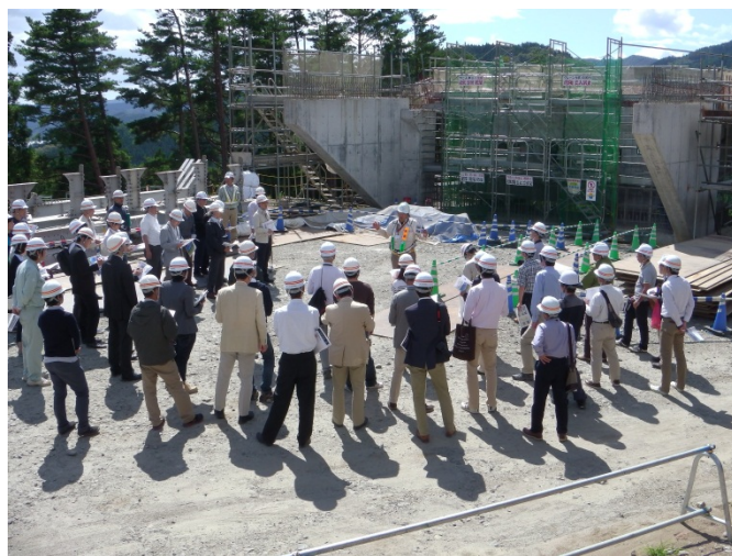
▲現場視察状況
