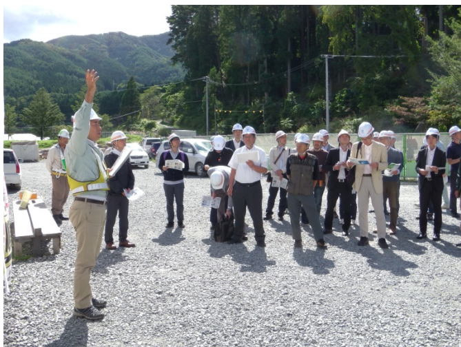
▲現場視察状況
